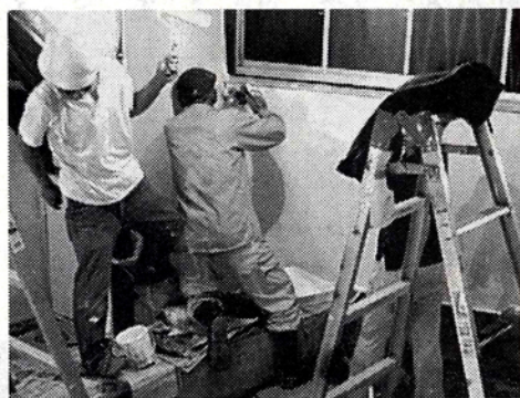
下町の人情に支えられて進んだ 空き家の改装工事—神戸市内で
