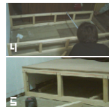
垂木で20cm上げ、床面にコンパネを張り付ける
