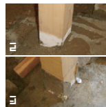
防腐のため根元をペンキ塗りし、アルミで覆う
