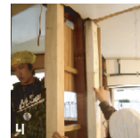
柱の間に垂木を組み、コンパネをはり付ける
